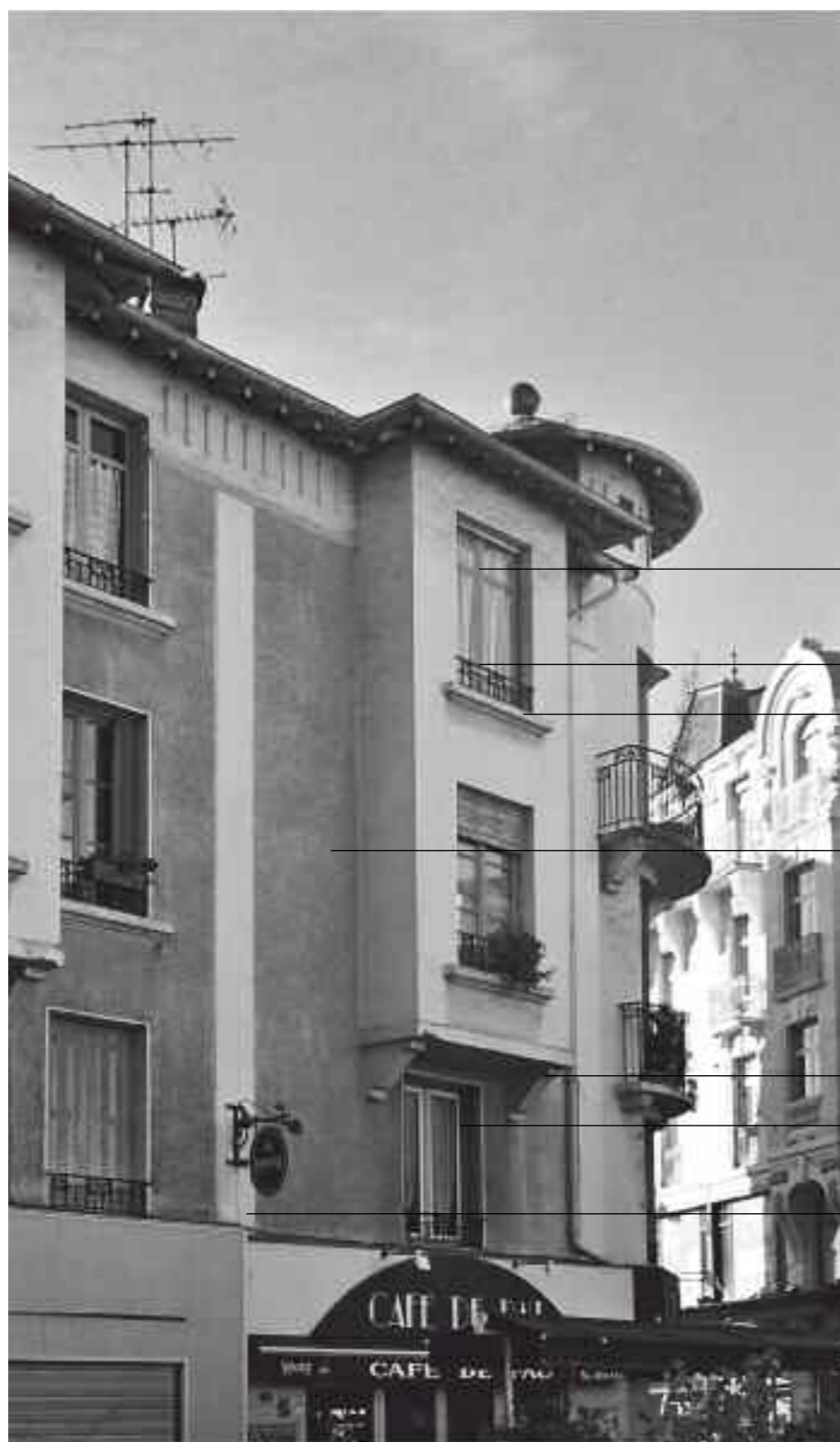
Détail de la travée sur l'oriel
