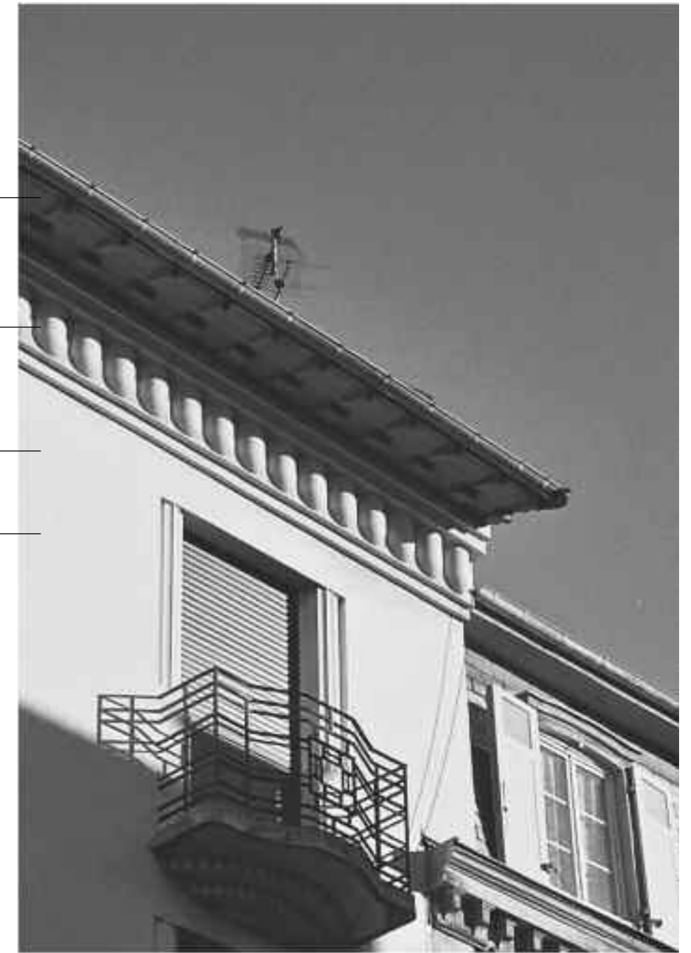
Détail du couronnement de l'immeuble : entablement et avancée de toit
