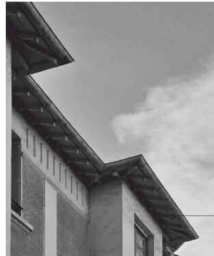
Détails du couronnement de l'immeuble : bandeau et avancée de toit
