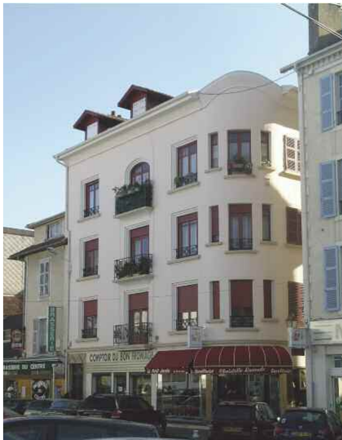
Rue de la République, récemment ravalé et remise en valeur par le traitement coloré qui souligne les éléments de modénature et de décor.
