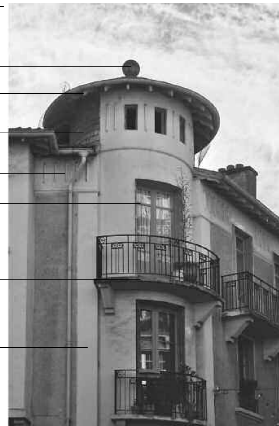
Détail de la travée de l'angle
