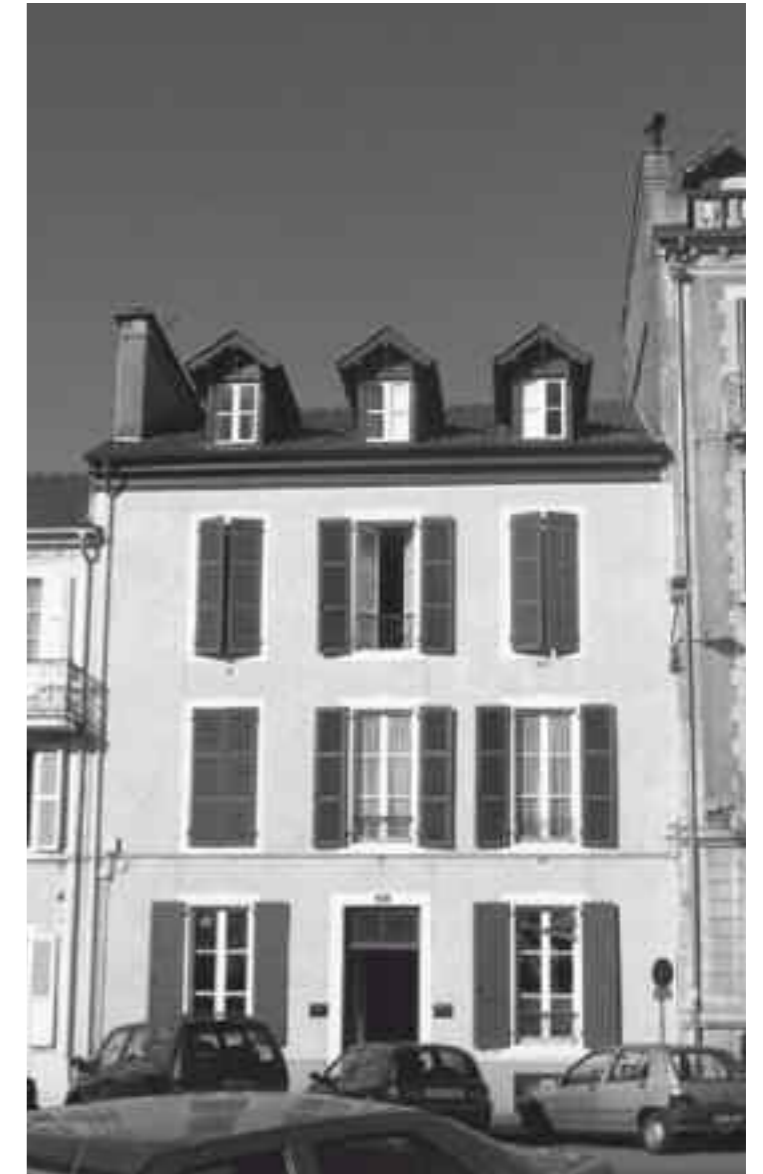
Cours Camou, rez de chaussé non commercial
