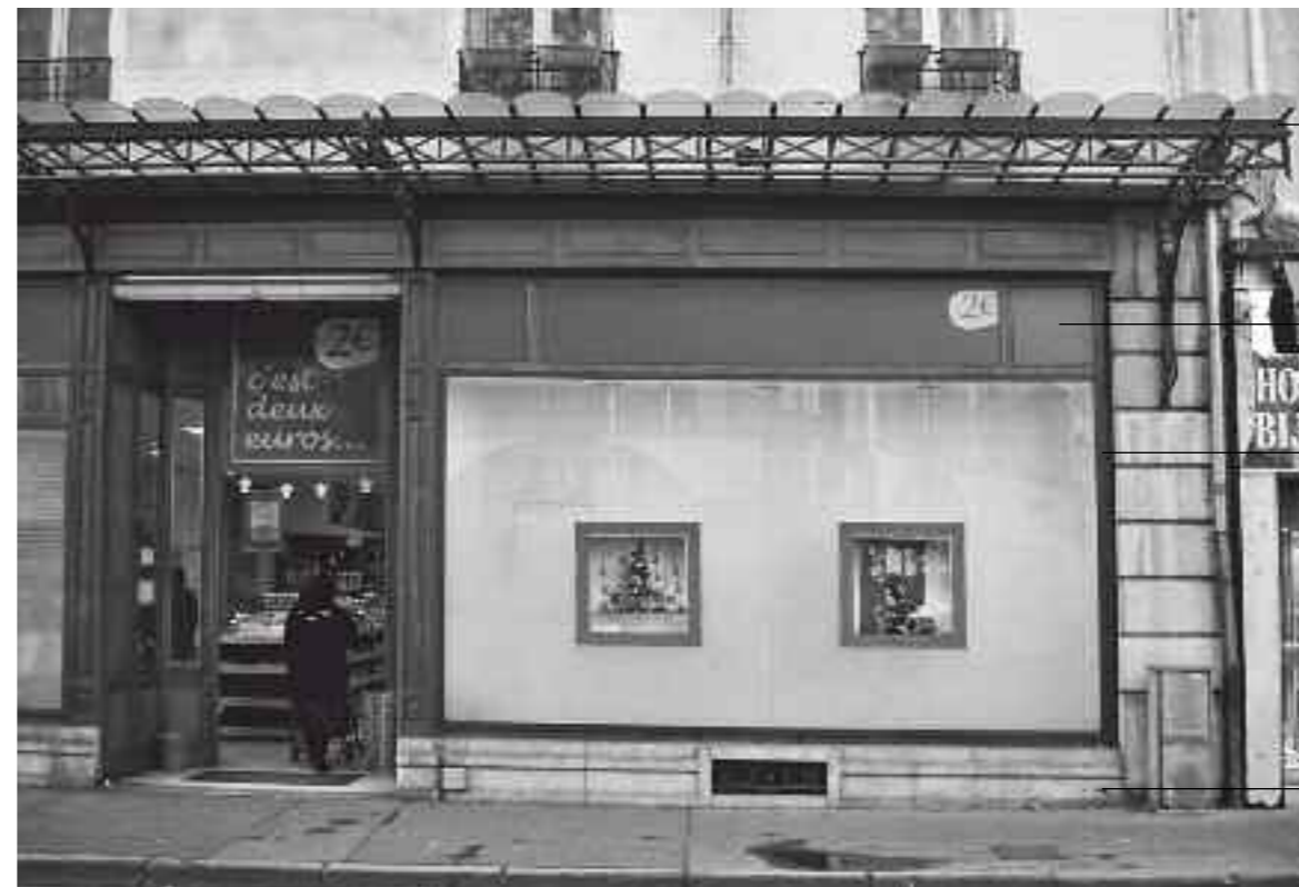
Marquise de protection en fer et en verre
