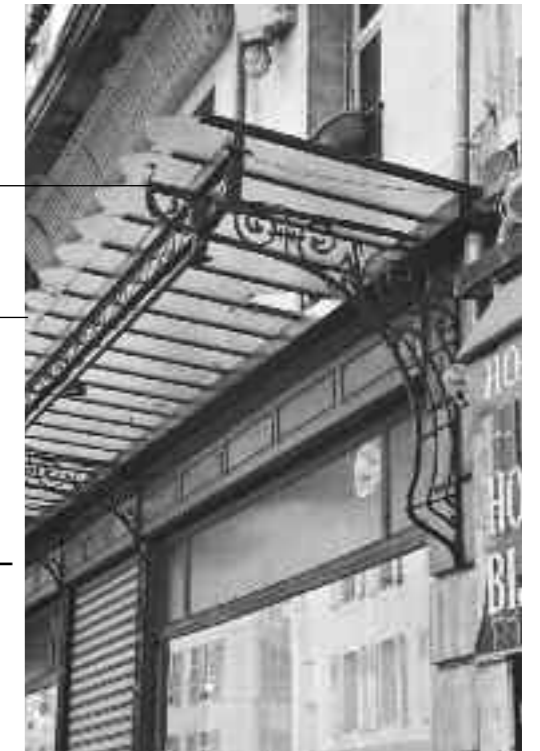
Détail de la marquise en ferronnerie
