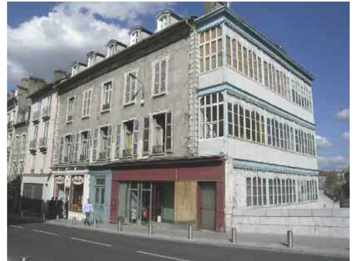
Rue Bordenave d'Abère, façade sur rue et façade sur le Hédas avec galeries en bois fermées et vitrées, orientées au Sud
