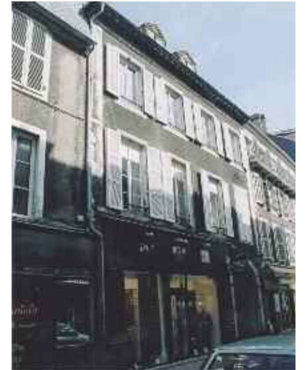
Menuiseries trop blanches
