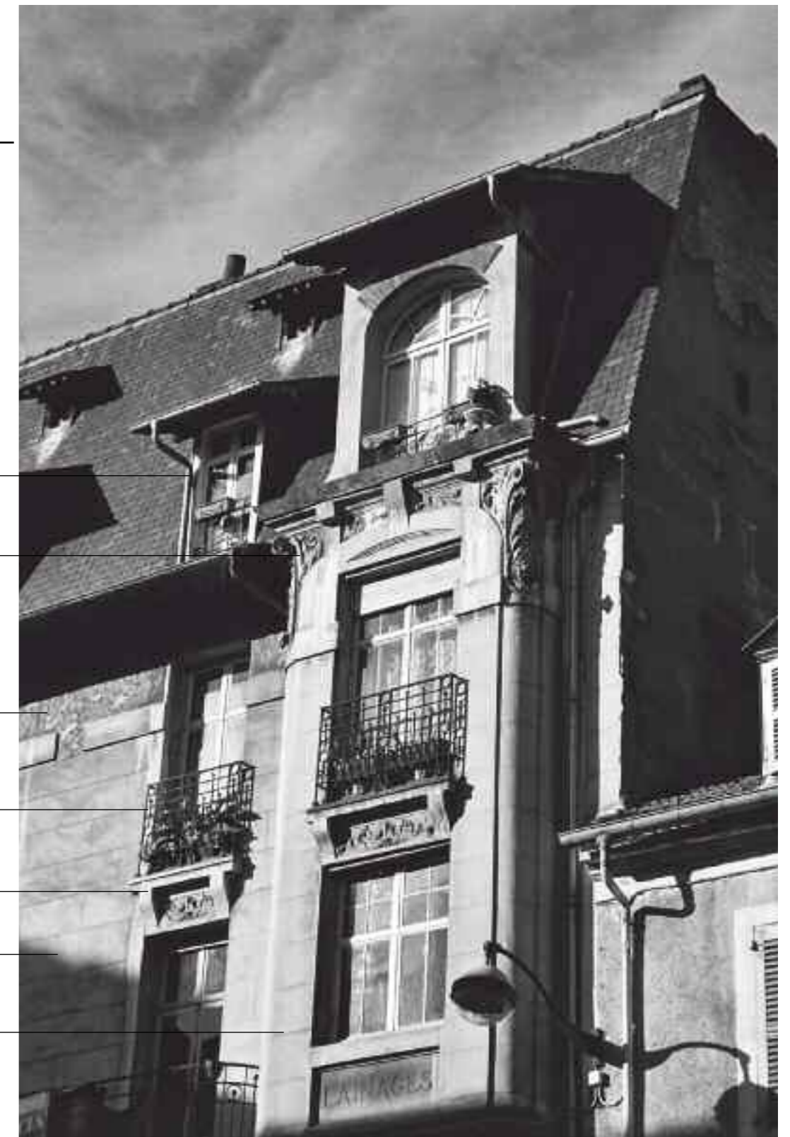
Détail de la modénature et de l'oriel latérale
