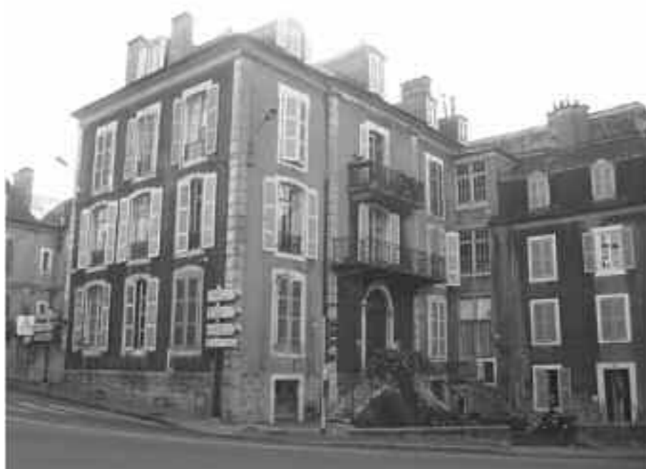
3, rue Lassansa, rue Espalungue
