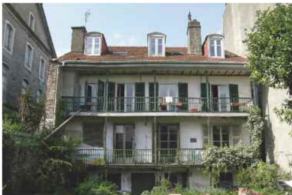
Rue Bayard, façade sur jardin avec galerie orientées au Sud
