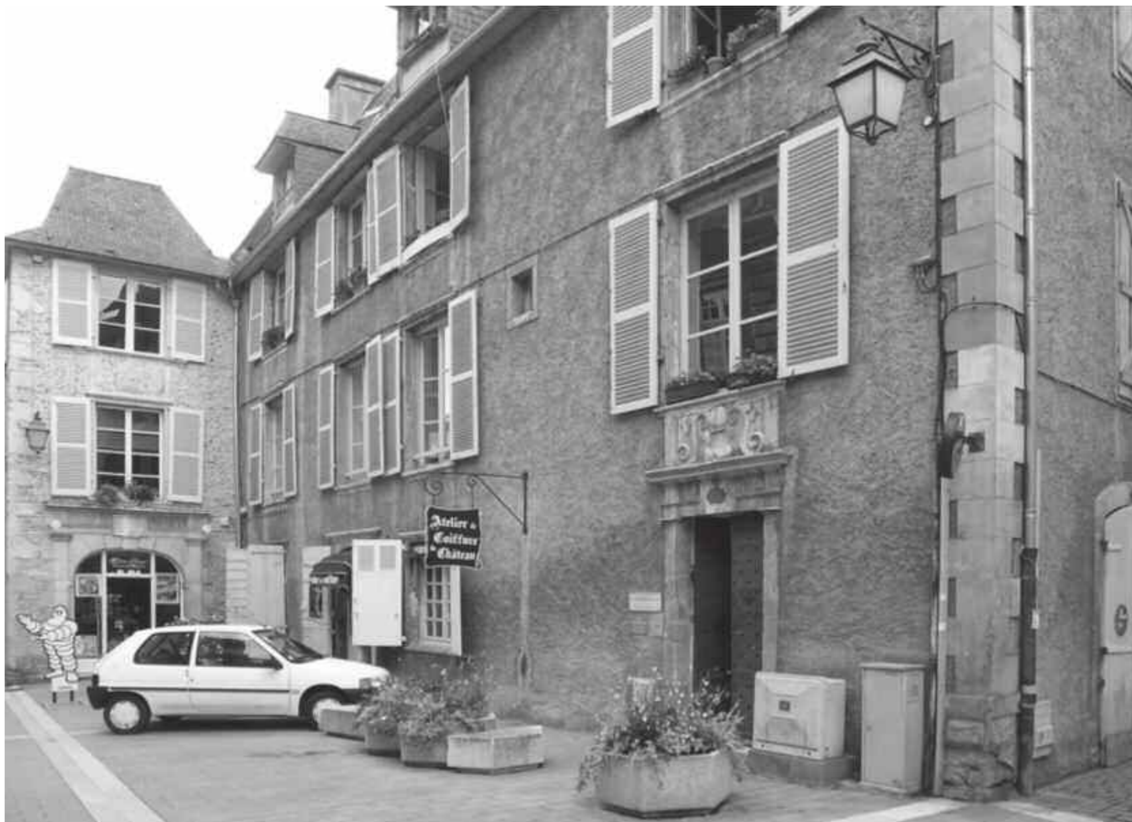
Hôtel particulier situé en face du Parlement de Navarre : cet édifice a conservé sa composition d'origine ainsi que la porte et le portail monumental et les encadrements des baies.
