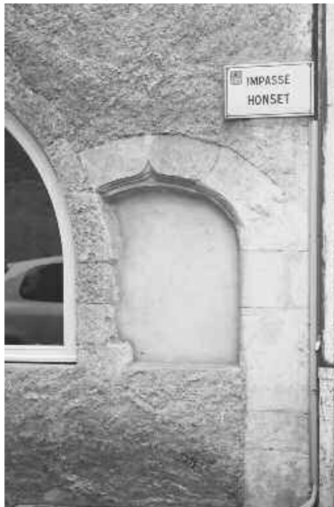
Détail de la baie située façade Est, arc en anse de panier à accolade
