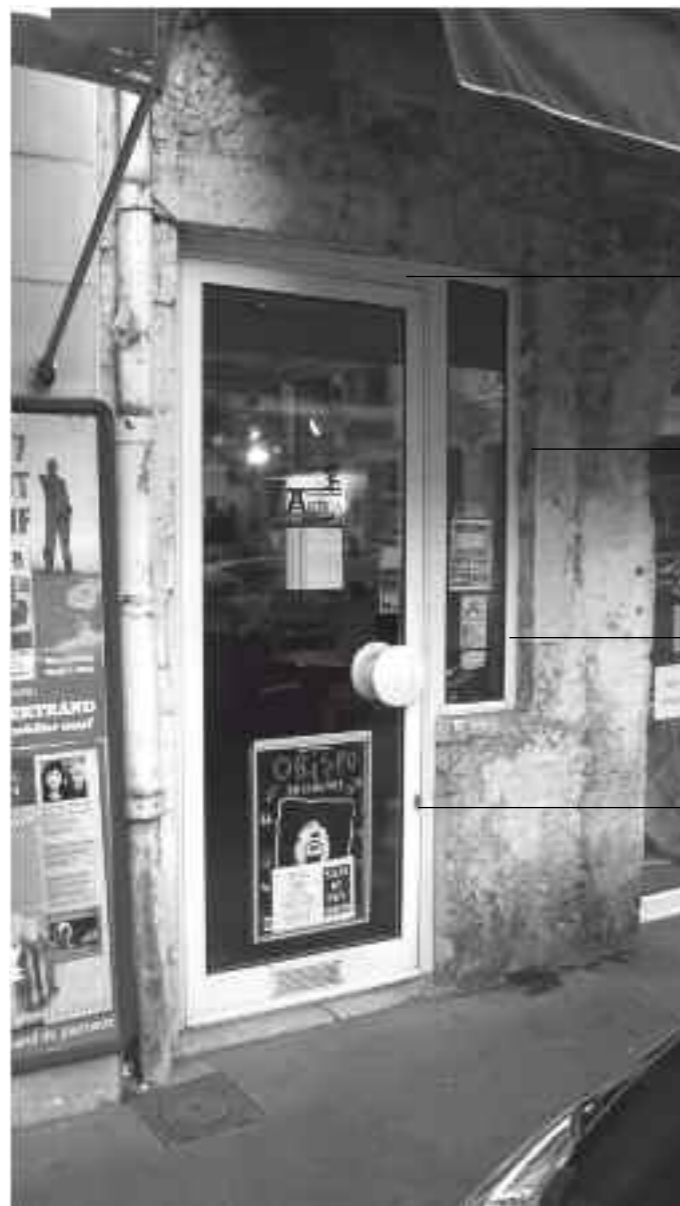
Détail de la porte d'entrée
