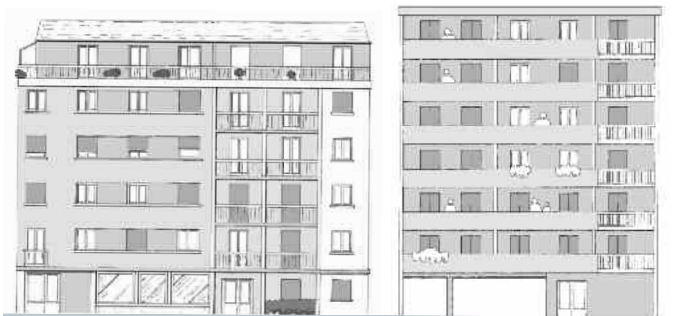
Sur ces deux façades, ce sont plutôt les éléments horizontaux qui ont été soulignés.
