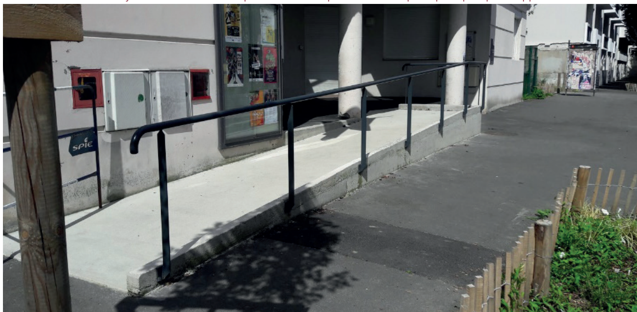
L'entrée du GS Léon Say avec création de la rampe d'accès et remplacement de la porte principale pour supprimer tous les seuils
