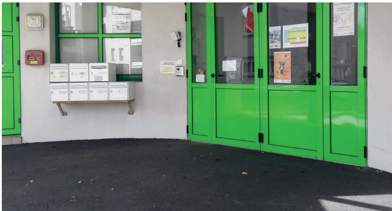
L'entrée du GS Léon Say avec création de la rampe d'accès et remplacement de la porte principale pour supprimer tous les seuils
