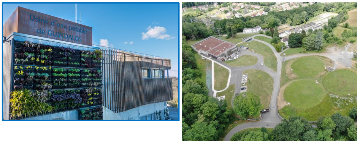
Figure 5. Site de Guindalos : Nouvelle usine
