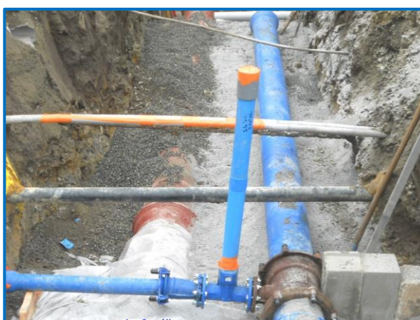
Figure 8. Travaux de renouvellement de réseaux
