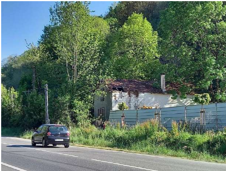
Vu du bâti de la parcelle AC n°157 depuis l'espace public
